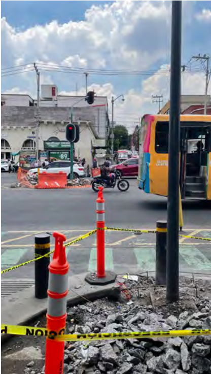
Etapa constructiva de un proyecto de rediseño de calle en Ciudad de México.
